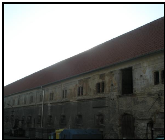
Fotografie před demolicí tzv. „teletníku“ – již je demolován 1 Zdroj: DBZ Tuchořice
